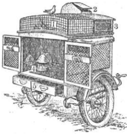
Рис. 1. Отдельная подвижная голубятня, может прикрепляться к автомобилю и к двуколесу: 1—ялетка, 2—откидной вход, 3—входной ящик, 4—резервуар для воды, 5—ящики для инструмента и корма.
